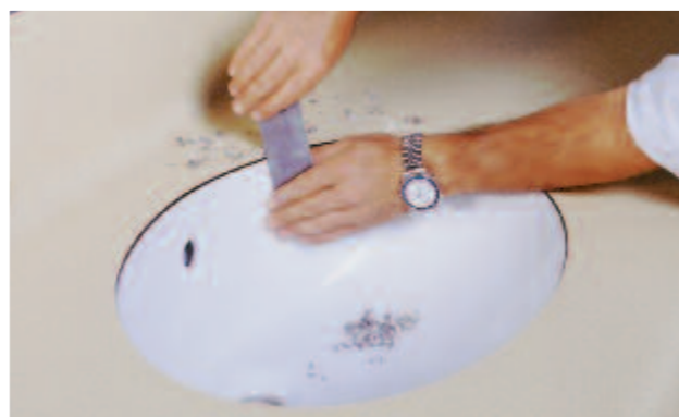
5. Začistit a dokončit začíšťovacím pilníkem a smirkovým papírem.
