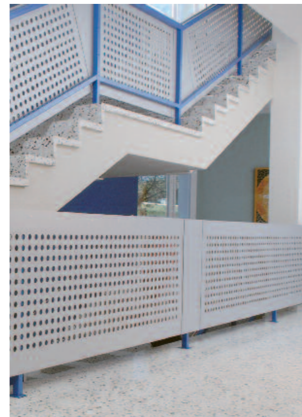
Příklad schodišťové výplně zábradlí – frézované otvory v MAX Alucompact 42
