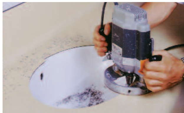
4. Zafrézovat přesah kompaktní desky na pohledové straně ruční honí frézou (šikmá fréza)
